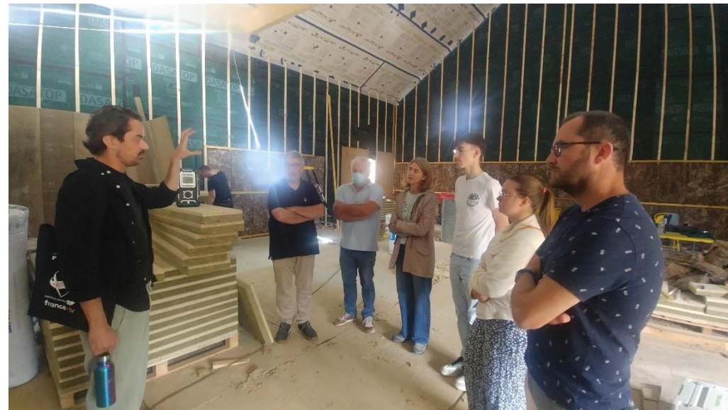
Construction de la salle polyvalente à Saint-Coulitz
